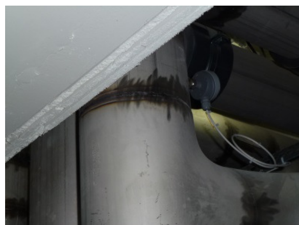
Bild 8 Svåråtkomligt utrymme för att putsa bort svetsoxider
