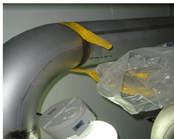
Bild 6 Kvarglömd svetsoxid som markerats för efterföljande putsning
