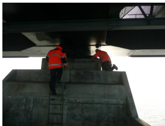
Bild 11-12 Lager på bropelare, Öresundsbron. Rostfria ståldelar i lager
