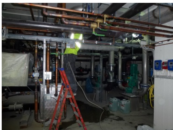
Bild 5 Besvärlig och trång miljö för att avlägsna svetsoxid på rörledningar i källarvåningen
